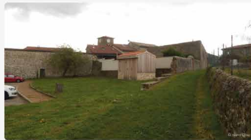
A Chuyer, poste électrique bien intégré dans son contexte malgré sa visibilité et utilisant un vocabulaire architectural local (bardage bois, soubassement en pierres, toitures à double pente en tuiles, légère avancée d'un fronton en façade évitant la décoloration de la façade par la pluie).
