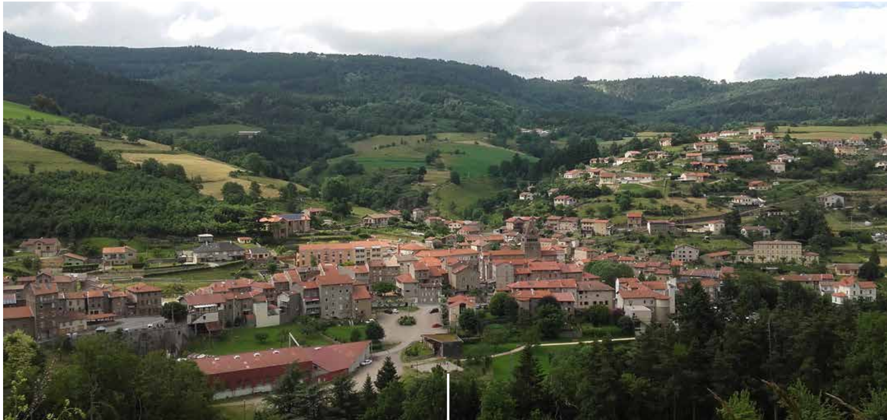
Chaudière à bois de St Sauveur-en-rue, implantée dans le tissu urbain.
