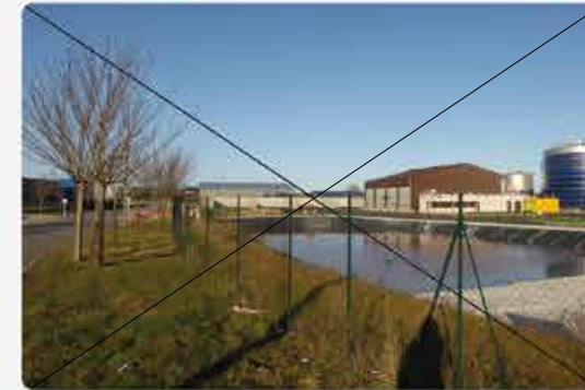
Contre-exemple d'aménagement sans qualité de bassin de gestion d'eaux pluviales d'une méthanisation, vers Montbrison
