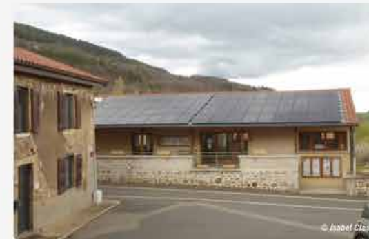
Toiture photovoltaïque sur un équipement à Chuyer
