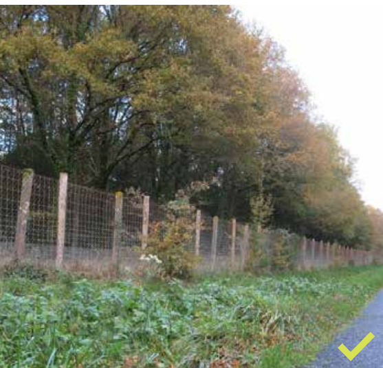
Double clôture en piquet châtaignier et grillage (deux rangs) - hauteur 2m.
