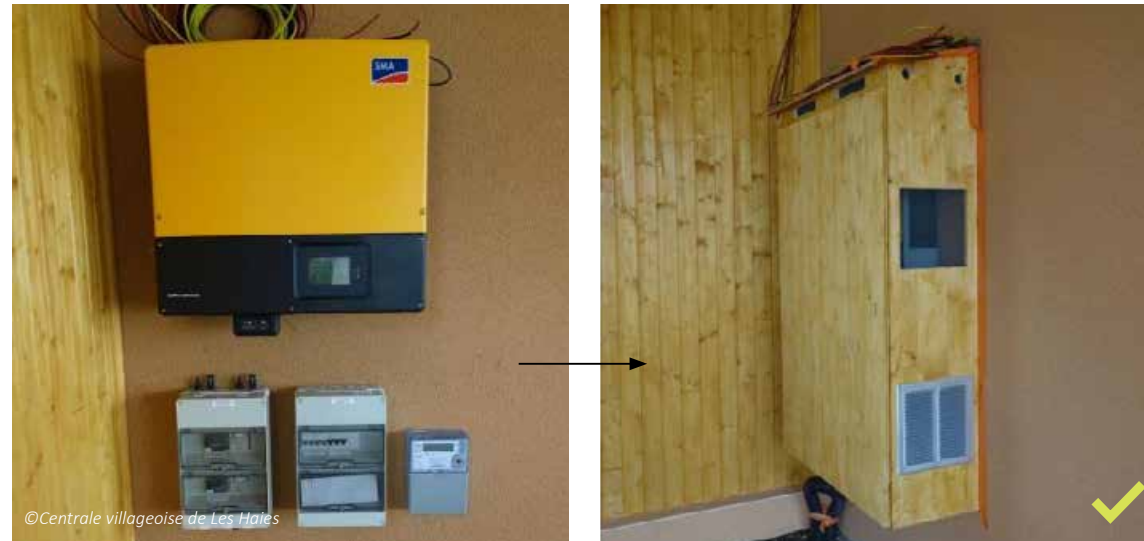
Boîtiers techniques et onduleurs insérés dans l'enceinte de l'équipement couvert par du photovoltaïque, comme ici à la centrale villageoise de Les Haies.
