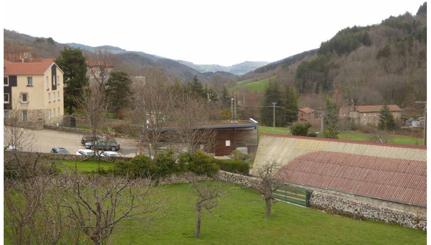
La toiture plate et végétalisée, la qualité d'implantation et les couleurs sombres ainsi que le bardage bois intègrent le bâtiment dans l'enveloppe de la vallée de la Déôme.
