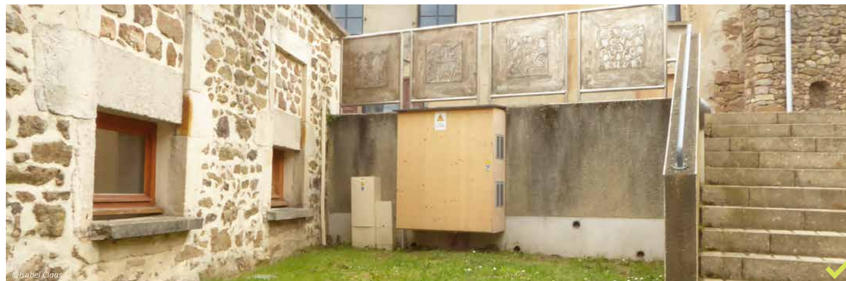
Boîtiers techniques et onduleurs insérés dans l'enceinte de l'équipement couvert par du photovoltaïque, comme ici à la centrale villageoise de Les Haies.
