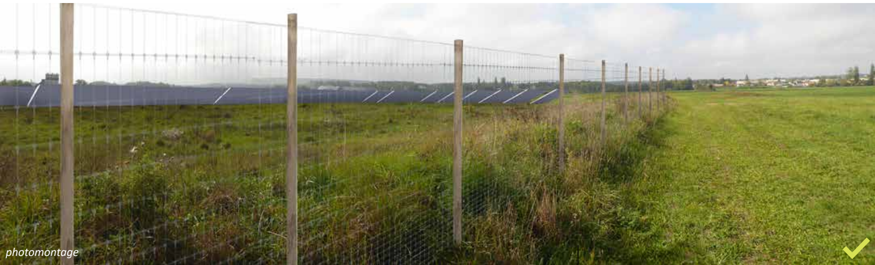
Simulation d'une clôture en piquets en châtaignier et grillage à maille progressive (ursus lourd), dont le bois s'harmonise dans le contexte agricole et naturel. Hauteur 2m Bande enherbée en pied de clôture avec fauche tardive
