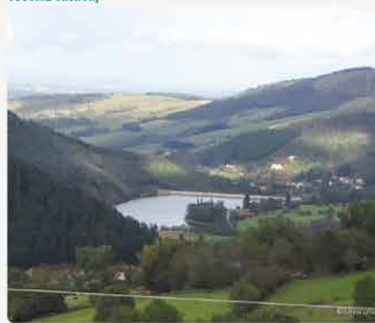
Barrage de la Terrasse-en-Dorlay pouvant faire l'objet d'étude de faisabilité pour l'aménagement de photovoltaïque flottant
