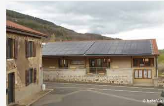
Toiture photovoltaïque sur un équipement à Chuyer
