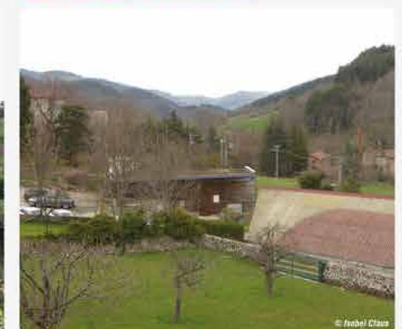
Chaudière à bois bien intégrée à St Sauveur-en-rue. La toiture plate et végétalisée, la qualité d'implantation et les couleurs sombres ainsi que le bardage bois intègrent le bâtiment dans l'enveloppe de la vallée de la Déôme.
