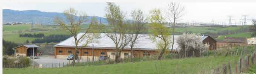
Couverture d'un hangar agricole couverte par du photovoltaïque. Quelques arbres existants en premier plan atténuent le volume bâti et le reflet, les Haies.
