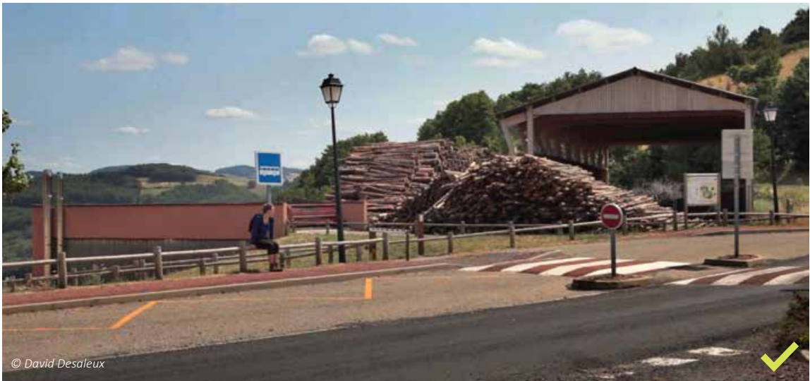
Chaudière à bois (toit plat avec cheminées) et plateforme de stockage de bois (grumes et hangar de séchage), accolées à l'entrée d'un village des Monts du Lyonnais. La toiture plate de la chaudière et sa situation en point bas laissent passer la vue vers le mont situé à l'arrière. L'usage du bardage bois et de teintes ocres harmonisent l'équipement dans son environnement.
