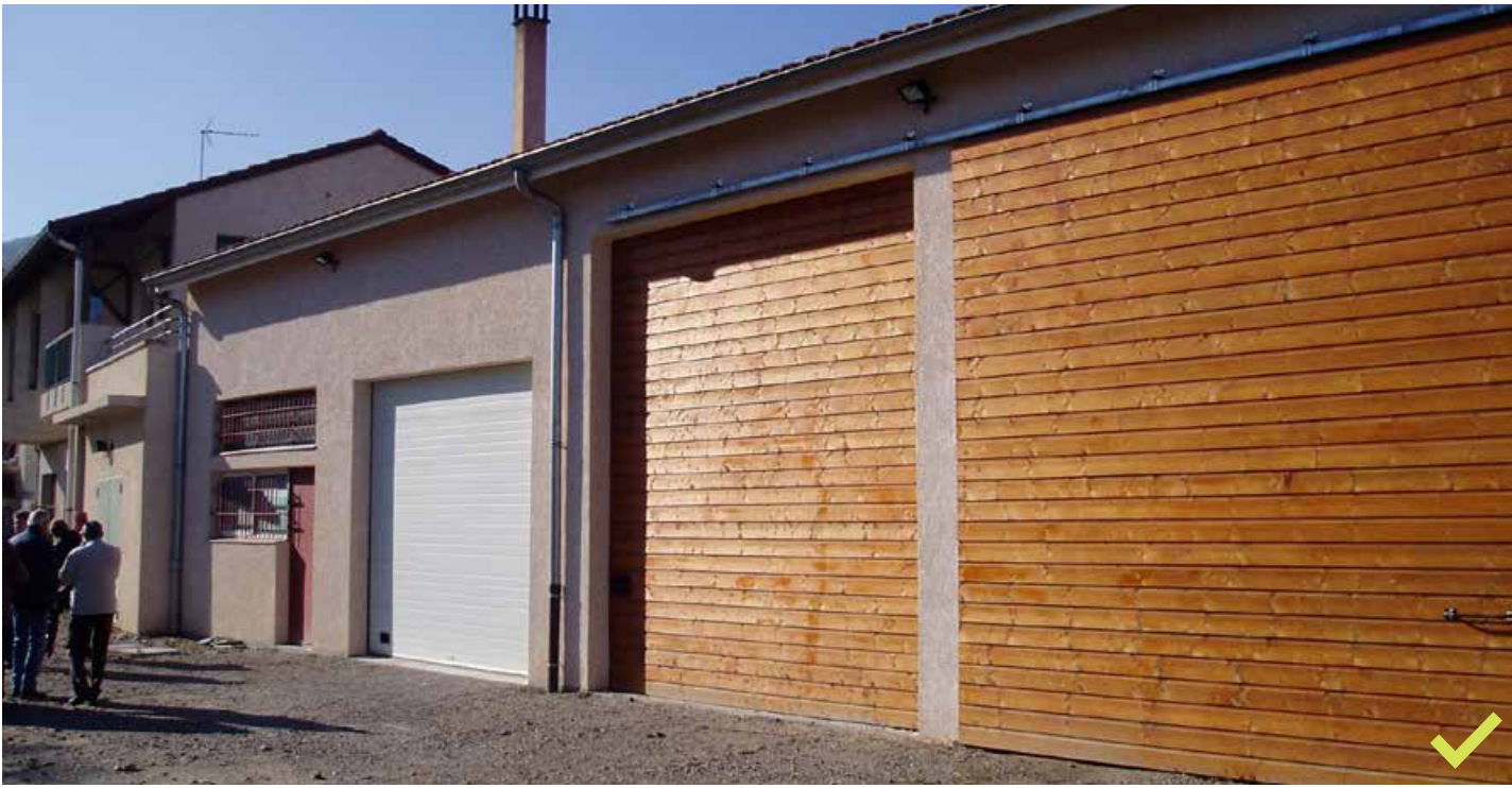
Chaudière-bois à Roisey, entièrement inscrite dans l'alignement de la façade existante (et mitoyenne), bardage bois en façade.
