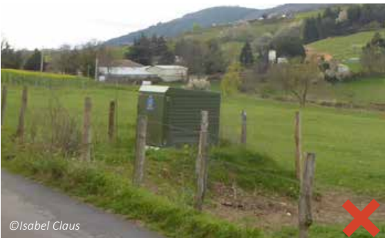
Ci-dessous, léger surhaussement du terrain et clôture à proscrire pour implanter un poste de transformation. Matériau non homogène avec le bâti alentour et construit (Rhône).
