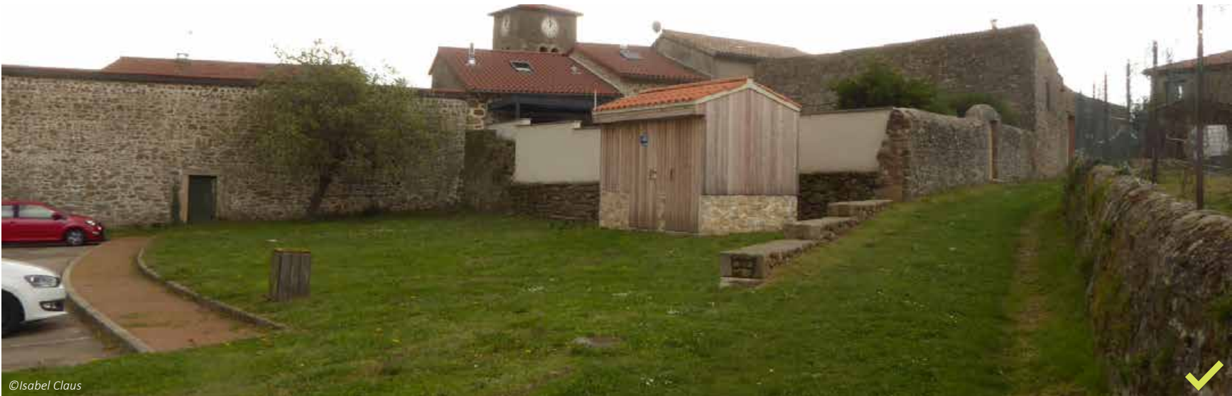
A Chuyer, poste de transformation électrique accompagnant la construction d'un lotissement proche (et non d'un projet ENR). Pour rappel, à ce jour, un transformateur est nécessaire pour les seules grandes installations ENR (environ 250 kwh, soit entre 1 000 et 2000 m² de toitures). L'exemple de Chuyer (sans lien avec les ENR), peut parfaitement s'adapter à des postes dédiés aux ENR.
